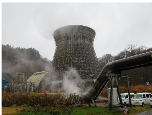
松川地熱発電所
